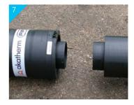
• innere Heizwendelschweißmuffe einseitig bis zum Mittenanschlag einschieben
