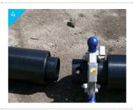
nach der mechanischen Bearbeitung der Oberflächen der zu verschweißenden Rohrleitungsteile die Rohrschnittkanten von Innen- und Außenrohr entgraten
