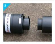
zweites Rohrende bis zum Mittenanschlag der inneren Heizwendelschweißmuffe einschieben
