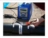
Nach erfolgreichem Schweißen und Abkühlen ist die Doppelrohrverbindung fertiggestellt und die Rohrleitung funktionsfähig.
