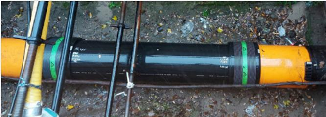
**Bild 3:** Muffen UB ohne Anschlag mit Stützhülsen und PE-Rohr-Passstück nach Standardnorm
