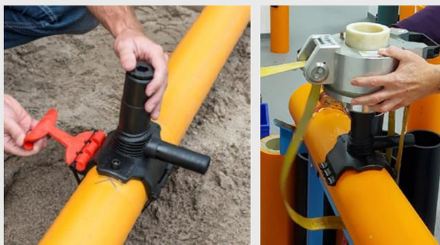
**Bild 9:** Aufspannung RED SNAP und Top-Loading im Vergleich
