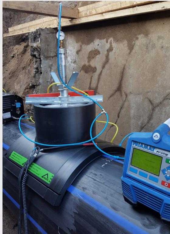
**Bild 12:** SA VL mit Vakuum aufgespannt
