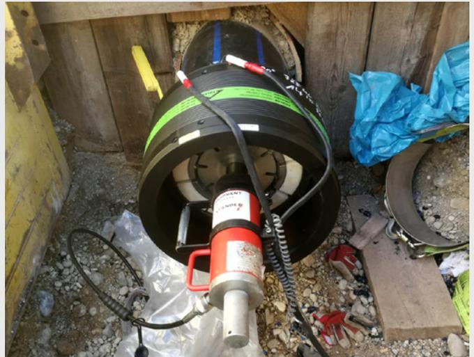
**Bild 5:** Temporäre Stützung mit Expander während der Schweißung
