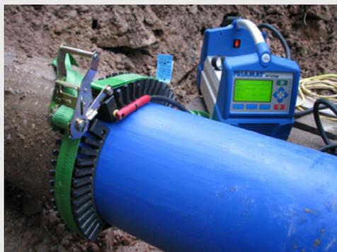
**Bild 7:** Aufgespannter FIXBLOC während des Schweißvorgangs
