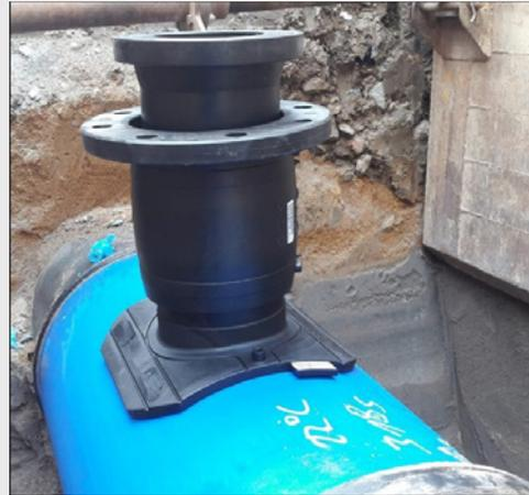
**Bild 11:** SA UNI mit Flansch d 160 / DN 150
